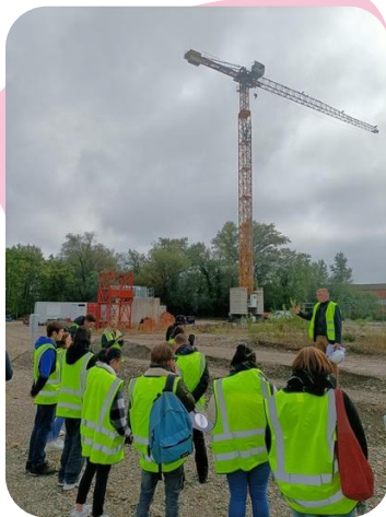
Visite de chantier |
